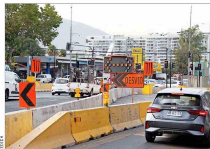
La autopista AVO II se conectará con Vespucio Oriente, entre La Reina y Peñalolén. Se espera el término de las obras para 2028.
