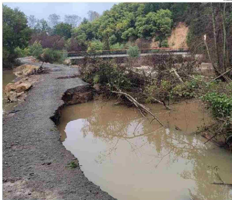
DE FONDO SE PUEDE OBSERVAR EL PUENTE CONSTRUIDO, DE CERCA EL BADÉN QUE USAN SIEMPRE.
