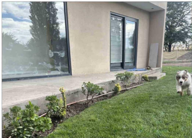
La presencia de un pequeño perro ha espantado los conejos.
