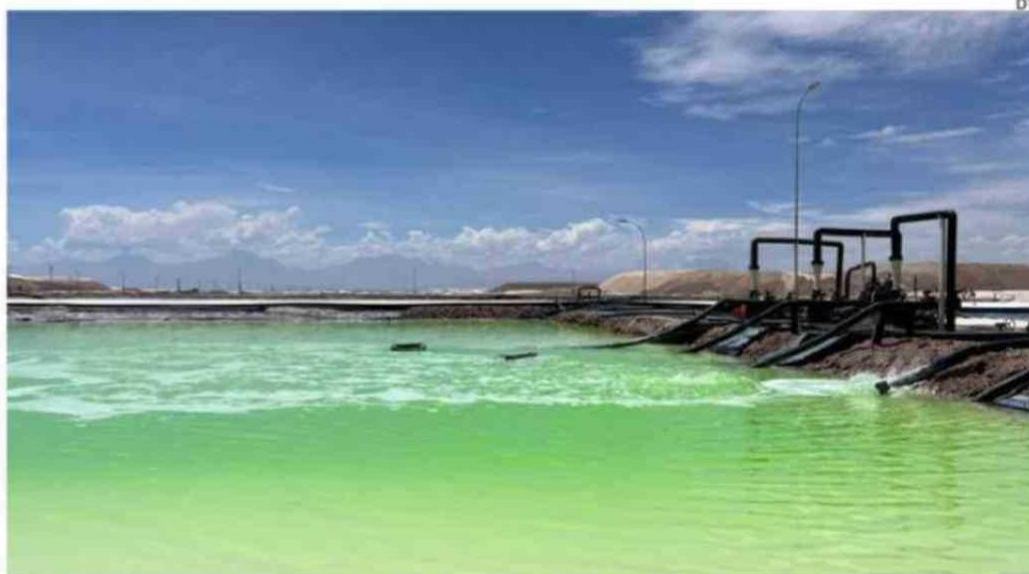
Ante el incumplimiento en la normativa la DT suspendió parcialmente las labores de ambas.
