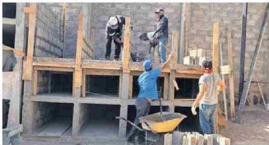
LAS OBRAS YA INICIARON EN EL CEMENTERIO MUNICIPAL
