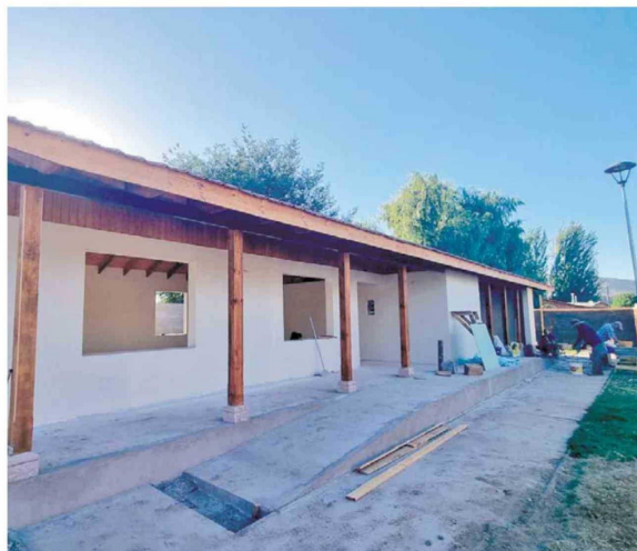
Se informó que la inspección técnica está a cargo de la Dirección de Obras Municipales de Coinco, asegurando el cumplimiento de las especificaciones técnicas.
