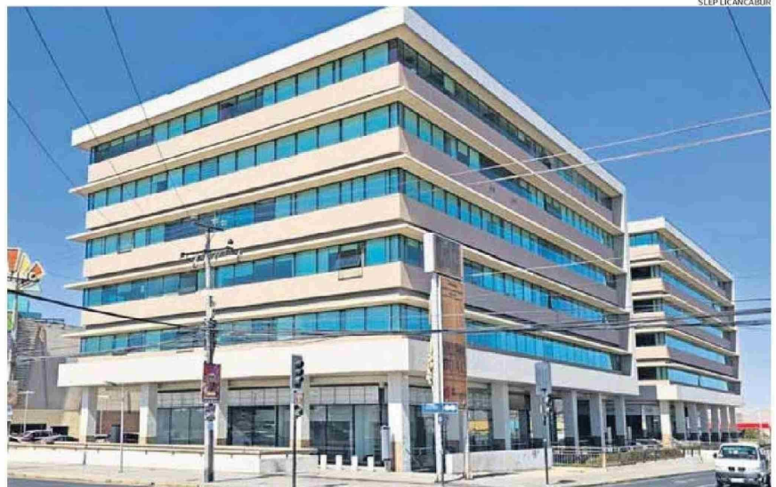
EL EDIFICIO EN DONDE OPERAN LAS OFICINAS DEL SLEP LICANCABUR, UBICADAS EN LA INTERSECCIÓN DE AVENIDA BALMACEDA Y CALLE CHORRILLOS.
