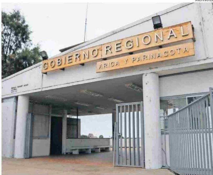
LA CONSTRUCCIÓN DE UN EDIFICIO PARA EL GOBIERNO REGIONAL FUE ANUNCIADO EN LA CUENTA PÚBLICA.
