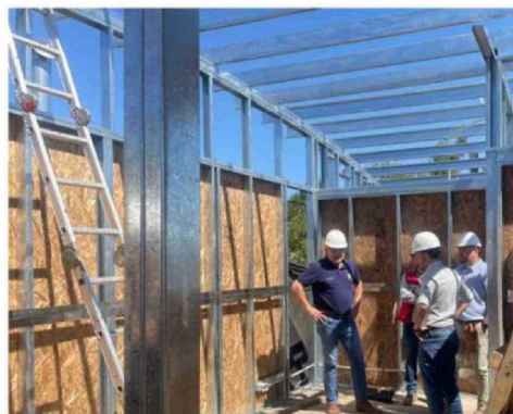
LA OBRA QUEDÓ CON UN 50% EN SU GRADO DE AVANCE.
