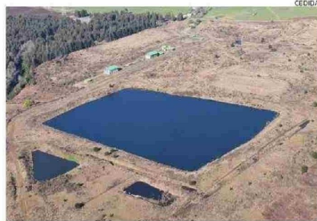
EL FRACASADO RELLENO SANITARIO QUEDÓ PARALIZADO EN 2015. EN EL TERRENO EN CURACO SÓLO HAY UN ENORME HOYO LLENO DE AGUA.
