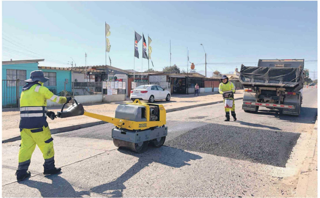
En el caso de La Serena, se usaron parte de los recursos en la instalación de lomos de toro y mejoras viales.
