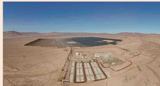
Servicio de Owner's Engineering para proyecto BESS Tamaya, Tocopilla (ENGIE). Capacidad: 68 MW / 418 MWh (152 contenedores de baterías).
