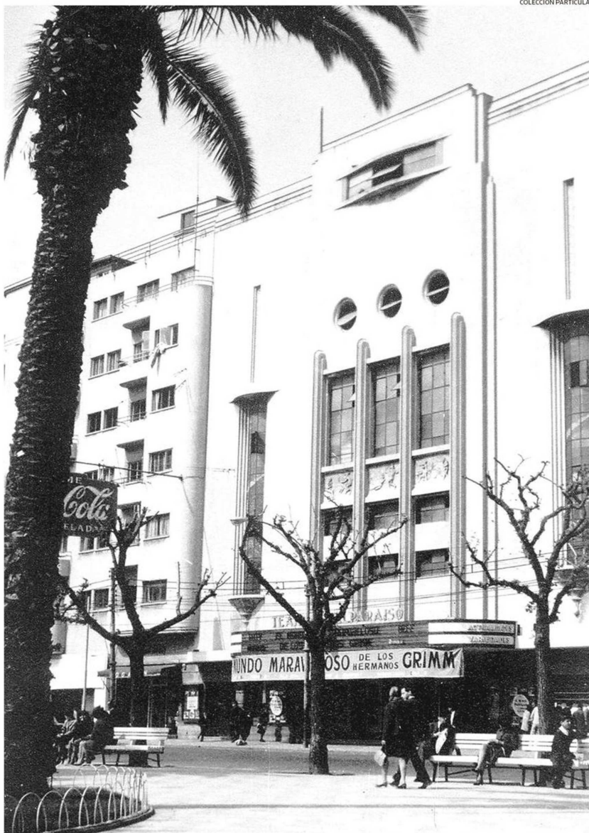
EL TEATRO VALPARAÍSO, FRENTE A LA PLAZA VICTORIA, DEMOLIDO EN 1998, CUANDO LA CIUDAD POSTULABA A PATRIMONIO DE LA HUMANIDAD.
