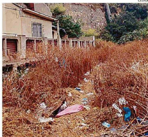
SECTOR DEL CERRO CORDILLERA EN CONDICIONES INSALUBRES.
