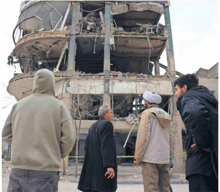
Edificio en Teherán donde funcionaban medios de comunicación alcanzado por bombardeo.
