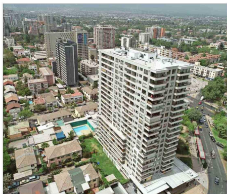
El Ministerio de Hacienda previno que la eliminación de la UF "sería un terremoto" para el mercado de los créditos hipotecarios.
