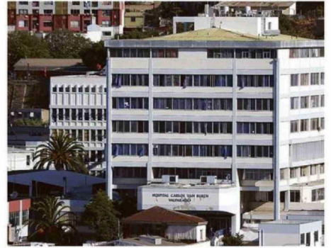
INFRAESTRUCTURA DEL RECINTO ES HOY INSUFICIENTE.
