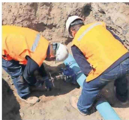
NUEVAS OBRAS PARA FORTALECER LA SEGURIDAD DEL SUMINISTRO
