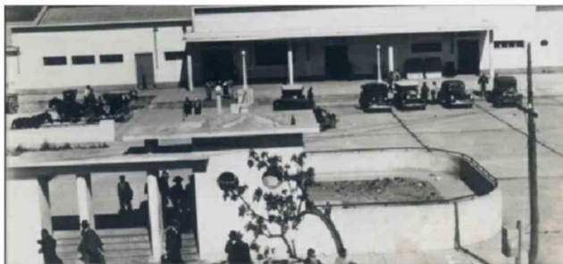
Estación FFCC de Linares, vista del frontis.
