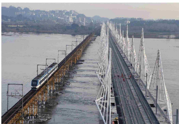
EL AVANCE VIAL PROYECTA SER UN GRAN PASO y beneficio para Biobío durante los próximos 50 a 60 años, considerando que fue diseñado para soportar y adaptarse al paso del tiempo.
