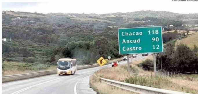
EL PRIMER TRAMO DEL MEJORAMIENTO DE LA PANAMERICANA CONSIDERA DESDE CHACAO A CHONCHI.
