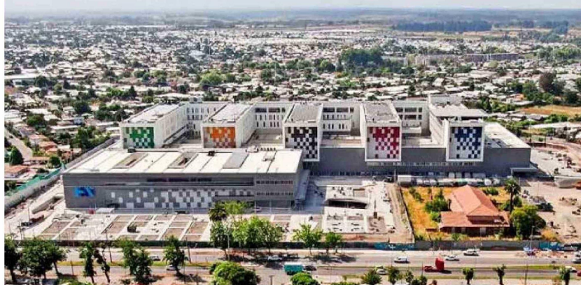
En 2019 fue el inicio de las obras del hospital de Ñuble, el que originalmente iba a estar listo en 2023. El presupuesto actual es de $256.000 millones, casi $100.000 millones más que el costo previsto en 2017.
