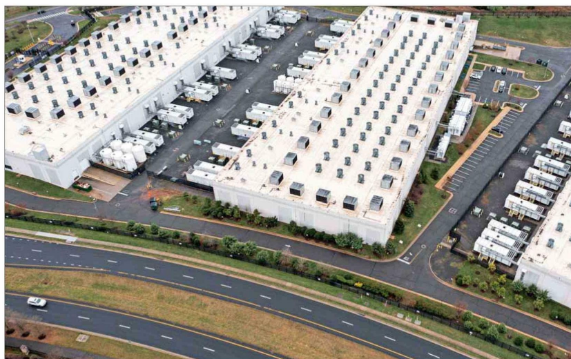
Un centro de datos de Amazon Web Services en Manassas, Virginia.
