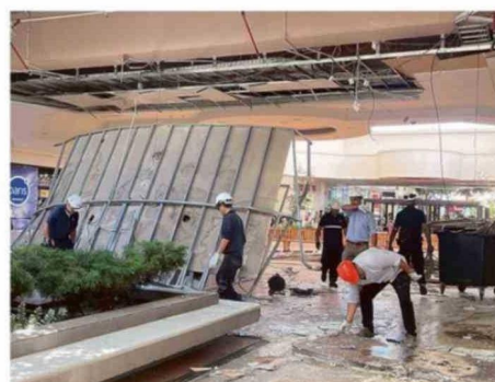
RETIRO DE ESCOMBROS OCASIONADOS POR EL DESPRENDIMIENTO.
