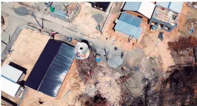
En El Pino, el incendio dañó gravemente la infraestructura de agua potable. Desafío Agua aporta soluciones inmediatas y, junto al MOP y vecinos, avanza en una solución definitiva.
