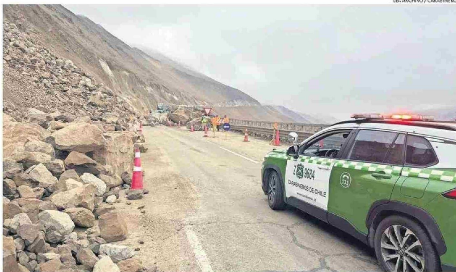
LOS DERRUMBES HAN CAUSADO QUE EL TRÁNSITO POR LA VÍA NO SEA FLUÍDO, LO QUE AFECTA ECONÓMICAMENTE.
