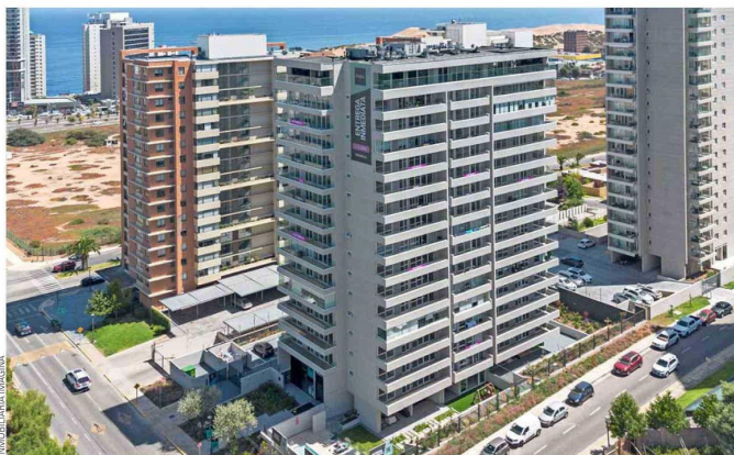
Uno de los proyectos emblema de Inmobiliaria Imagina es el edificio Smart Montemar ubicado en Con Con.
