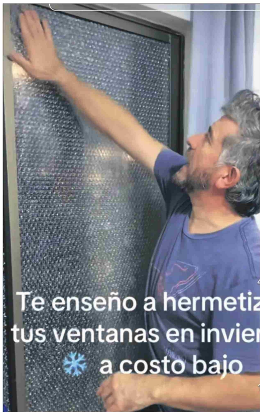
La cámara de aire de las burbujas permite retardar el punto de rocío, que produce que se junte humedad en los vidrios.
