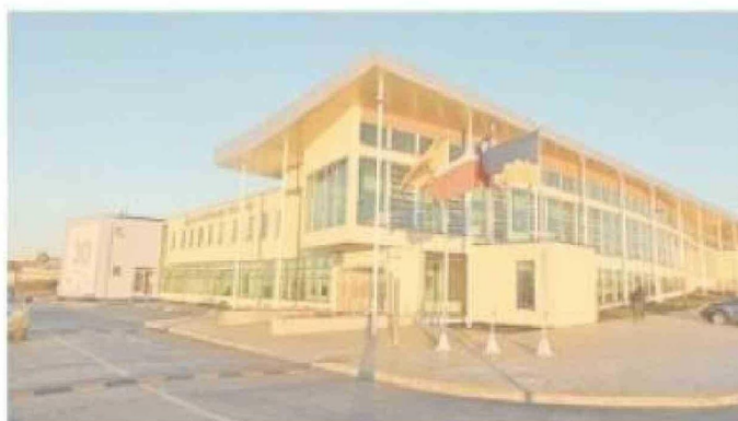
La jornada se realizará en la sede del Centro de Rehabilitación.
