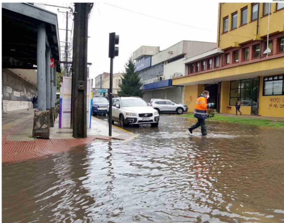
ESTE PUNTO DE LA CALLE BENAVENTE, EN PLENO CENTRO DE PUERTO MONTT, SE INUNDA CUANDO LLUEVE DE FORMA INTENSA EN POCO TIEMPO.
