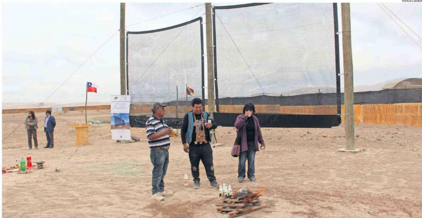
ESTE SISTEMA PILOTO DE ATRAPANIEBLA, CAPTURA AGUA DE LA CAMANCHACA CON DOS MALLAS DE 16 METROS CUADRADOS CADA UNA.
