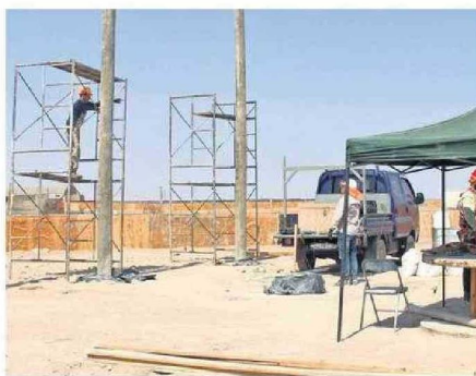
DURANTE LA ETAPA DE CONSTRUCCIÓN.
