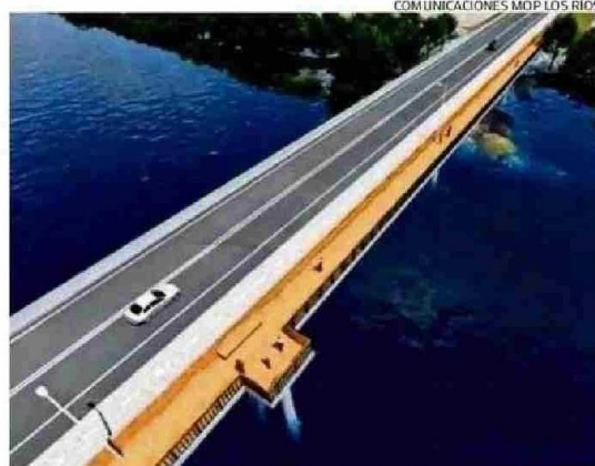
LA OBRA INCLUYE UN PUENTE DE 140 METROS DE LARGO.
