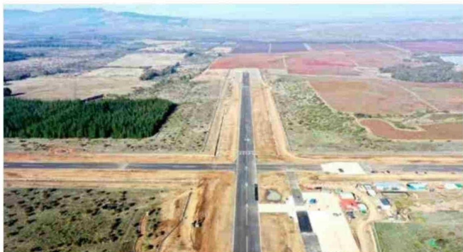
Más de 23.000 mil millones se invierten en el mejoramiento del Aeródromo El Boldo, para transformarlo en un centro de desarrollo para la región.
