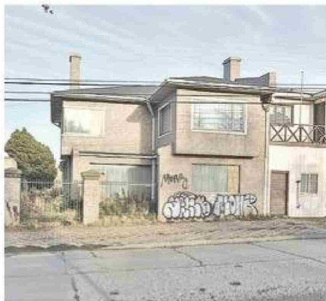
En Avenida Independencia, en la propiedad que perteneciera al magallánico Jaime Gutiérrez Varillas, se construirá el Centro Médico de Carabineros.
