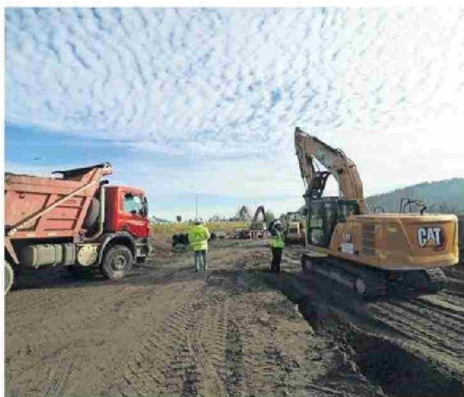
Los trabajos consideran una inversión de $14 mil millones.
