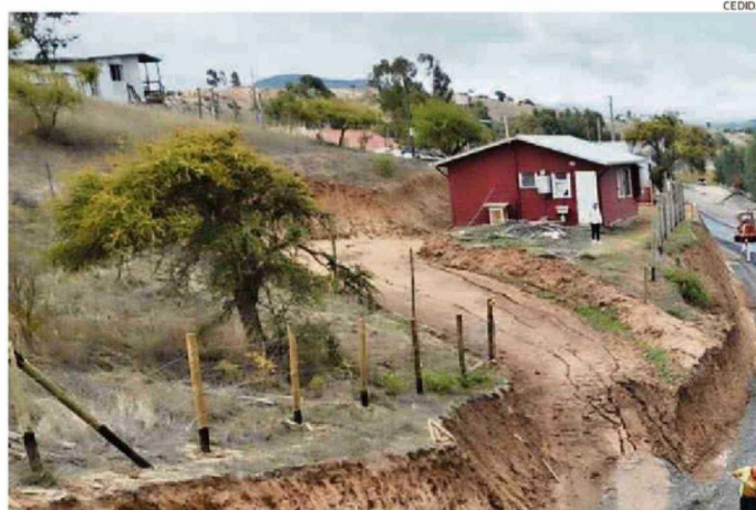
TRABAJOS SE DESARROLLAN EN DISTINTOS FRENTE ENTRE LOS KILÓMETROS 0 Y 12,5 DE LA RUTA.
