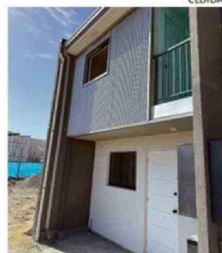
OBRAS DE MÁS DE MEDIO CENTENAR DE VIVIENDAS DETENIDAS.
