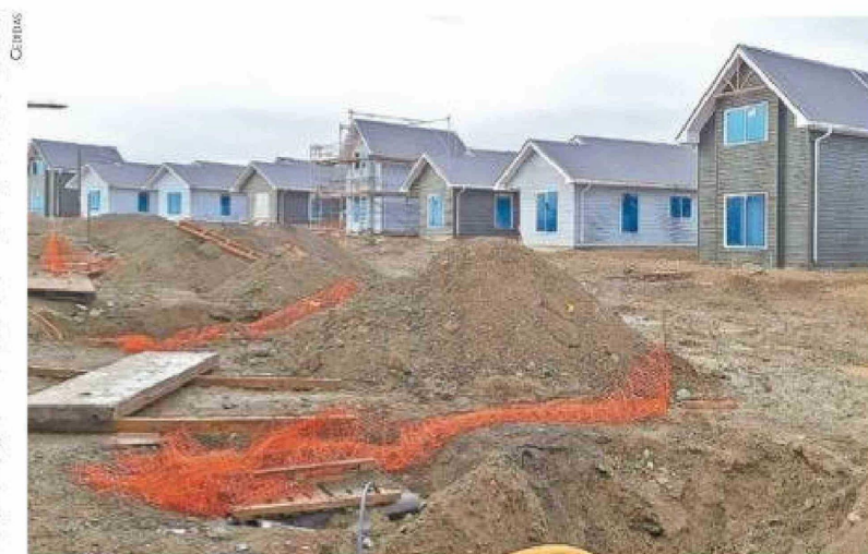
Las 49 soluciones habitacionales del subsidio rural, traducidas en viviendas sociales, conforman el loteo ya construido, cuya entrega se espera para inicios del próximo mes, en un terreno que bordea el río Side, en la parte baja de Cerro Sombrero.
