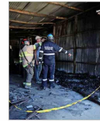
El fuego destruyó bodegas de centro de entrenamiento.
