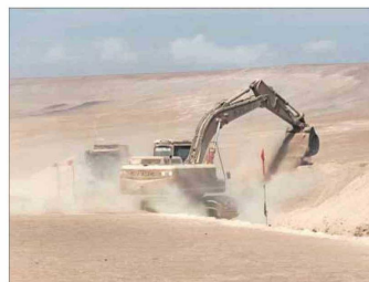
Las retroexcavadoras se encuentran en plena operación en la zona limítrofe con Perú, uno de los puntos por donde entran los indocumentados.
