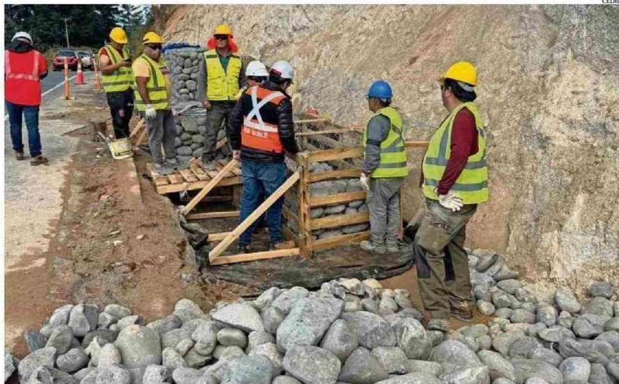
INVERSIÓN DE OBRAS QUE PERMITIERON DOTAR DE ENROCADO EN ZONA COSTERA DE COELEMU LLEGÓ A LOS 2.648 MILLONES DE PESOS.
