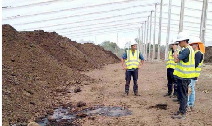
LOS FISCALIZADORES DE LA SMA HAN ESTADO EN VARIADAS OCASIONES EN LA PLANTA DE COMPOSTAJE DE CRUCERO.
