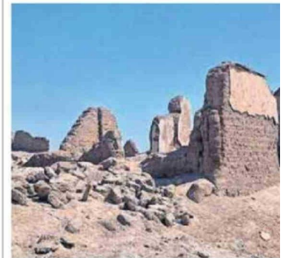
LOS EFECTOS DEL TERREMOTO FUERON CATASTRÓFICOS.
