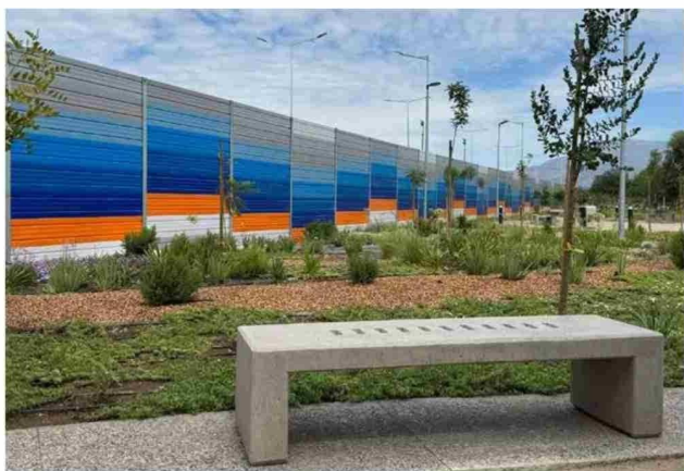
Barrera acústica absorbente Parque Serrano, Pudahuel.
