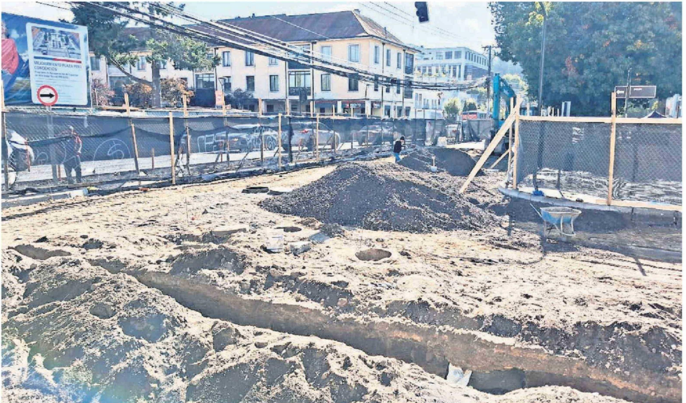
LAS OBRAS EN LA AVENIDA CHACABUCO ESQUINA PAICAVI (FRENTE A LA CASA DEL ARTE DE LA UDEC) Y LOS DE MEJORAMIENTO DE LA PLAZA PERÚ HAN IMPACTADO EN EL TRÁNSITO DE LAS PERSONAS.
