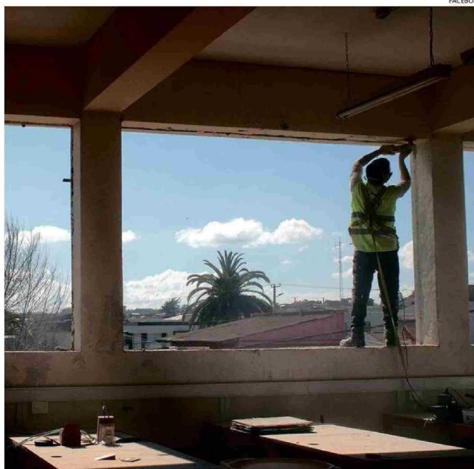
LAS ANTIGUAS VENTANAS DEL ESTABLECIMIENTO DATAN DE 1958.
