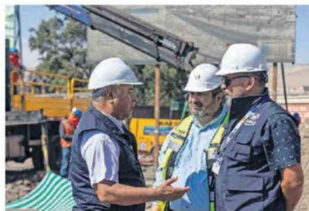
ALCALDE VARGAS VISITÓ LAS OBRAS.
