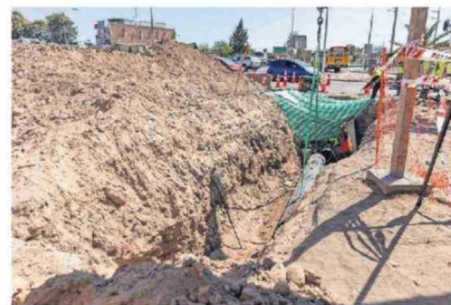
OBRAS AVANZAN RÁPIDAMENTE.
