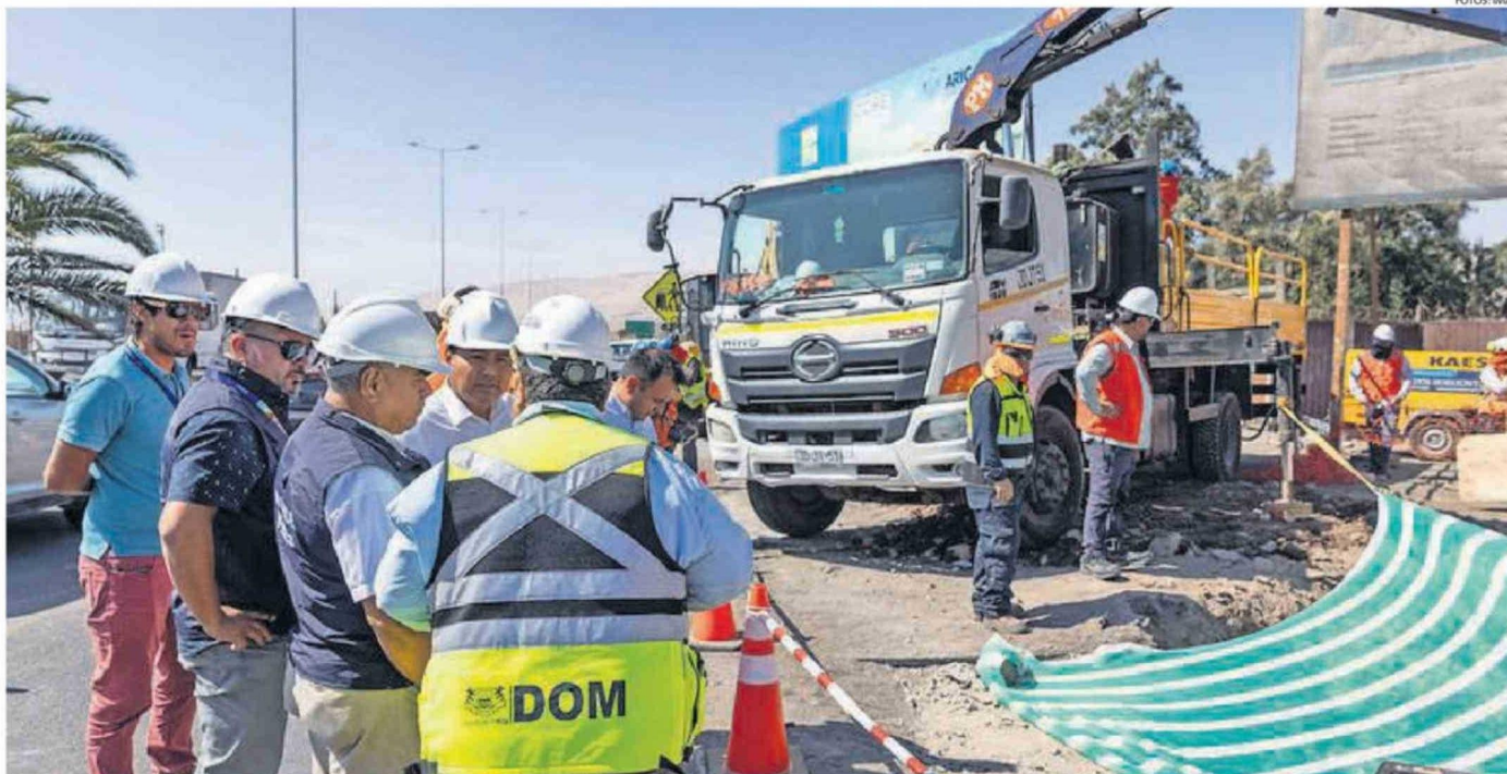
EL PROYECTO CONTEMPLA LA INSTALACIÓN DE SEIS KILOMETROS DE POSTACIÓN CON 168 POSTES DE ACERO GALVANIZADO, 336 LUMINARIAS LED, Y 6 MIL METROS DE CANALIZACIÓN Y CABLEADO.
