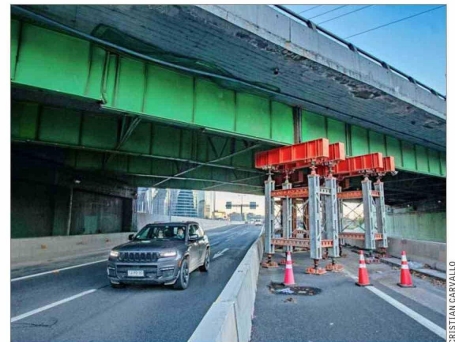
INFRAESTRUCTURA. — Fue construido a inicios de la década de 1970, por lo que resistió los terremotos de 1985 y 2010. No está concesionado, por lo que su conservación y mantención dependen exclusivamente del MOP.
