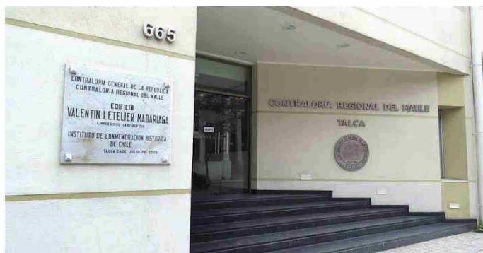
Sede la Contraloría Regional del Maule. En el 2009 colocamos esta placa y dimos el nombre de Letelier al edificio, previa aceptación del contralor Ramiro Mendoza.
