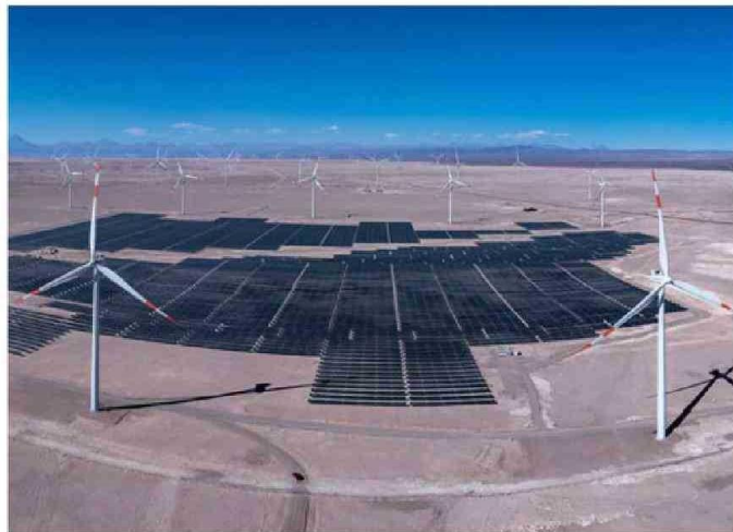
Proyecto de Enel se integrará a un complejo renovable que combina generación solar y eólica, y almacenamiento en un mismo sitio.
